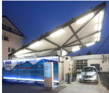
Links: Öffentliche, solare Wasserstofftankstelle des Fraunhofer ISE. © Fraunhofer ISE Rechts: Autonomer, außertauglicher Teststand zur parallelen Untersuchung von dreißig Testzellen. © Fraunhofer ISE
